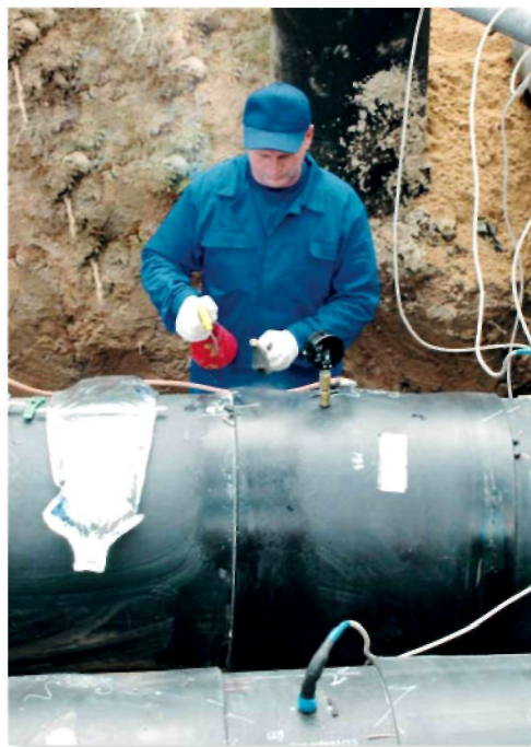
В Мытищах произведена замена 80% устаревших теплотрасс на современные
